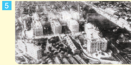
病院大改築の様子
