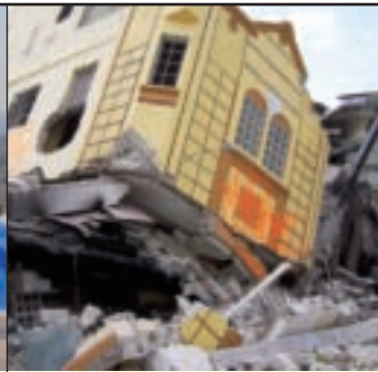
地震により倒壊した建物
