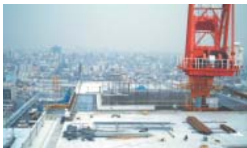
屋上部分建設現場のようす
